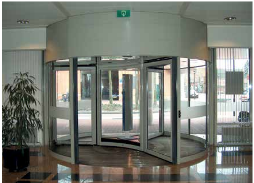
La cortina de aire para puertas giratorias calienta el aire frío que entra del exterior y mantiene el confort
