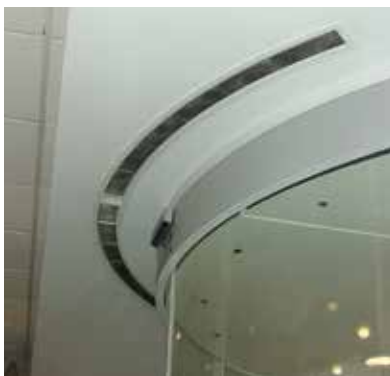
La rejilla de difusión está perfectamente adaptada a la sección abierta de la puerta giratoria.
